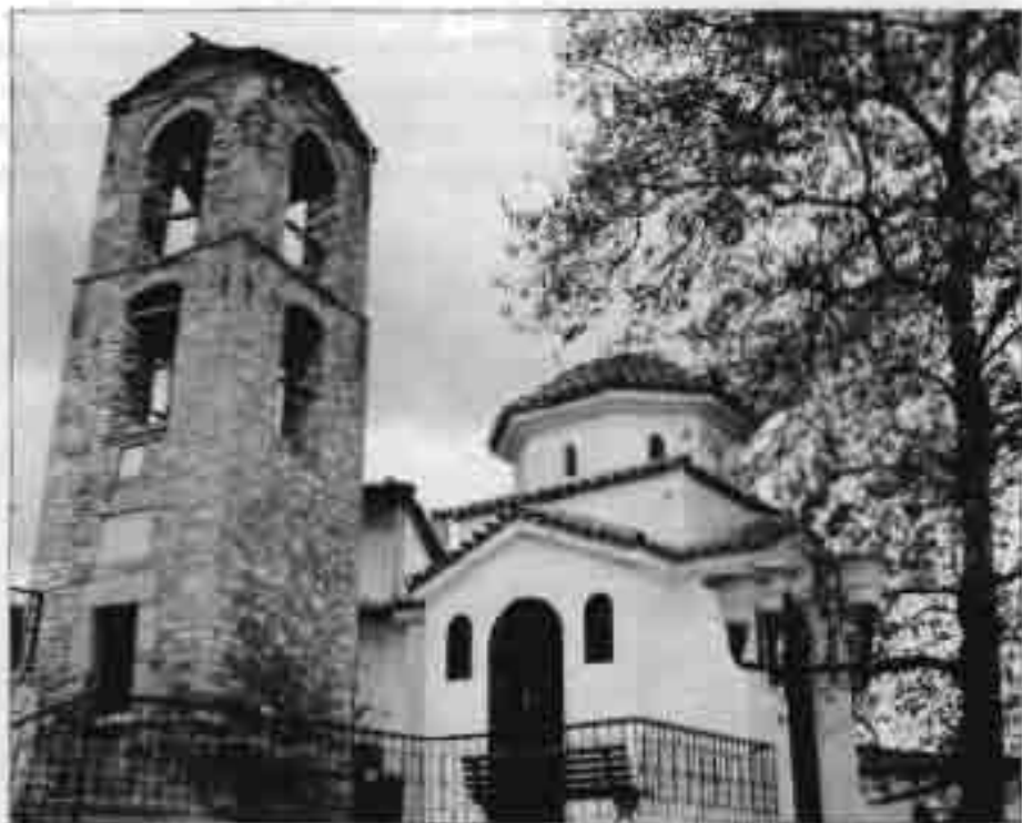
Καμπαναριό LN. Αγ. Νικολάου Μελίβοιας.
