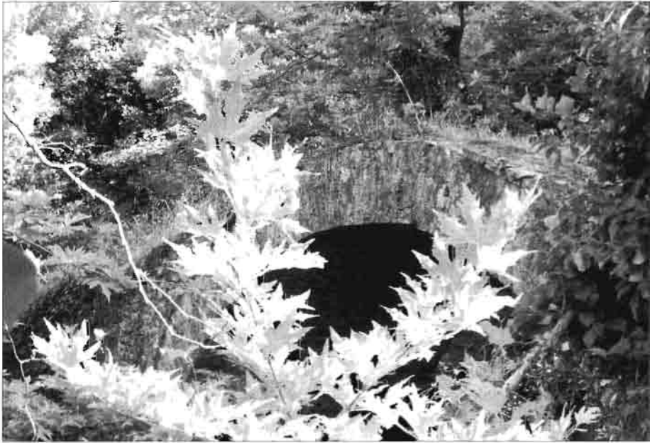
Γέφυρα Παλαριζαινας στο Κόχκινο Νερό.
